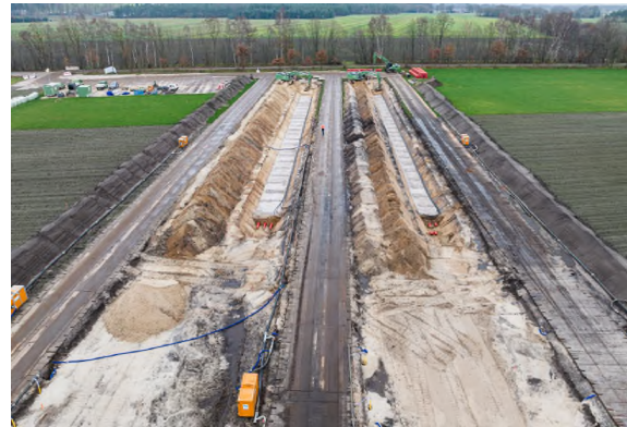
Beispiel einer etwa 75 m breiten Kabeltrasse (©rhein-main-link.amprion.net)
